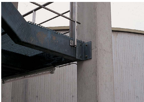
Монтаж лестничных маршей
