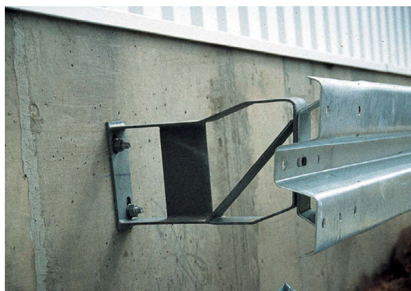
Монтаж дорожных ограждений
