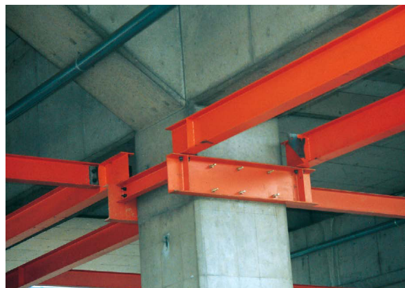
Монтаж металлоконструкций
