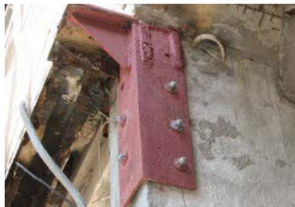
Монтаж опорного столика
