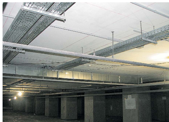
Монтаж спринклерных систем пожаротушения
