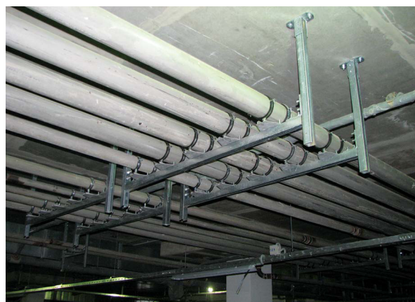
Монтаж инженерных систем
