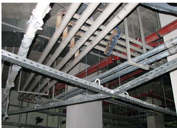
Монтаж инженерных систем
